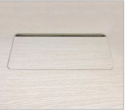
Accès supérieur du câblage "M"
