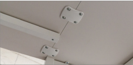
Fixation des retours auxiliaires sur la surface inférieure du plateau.
